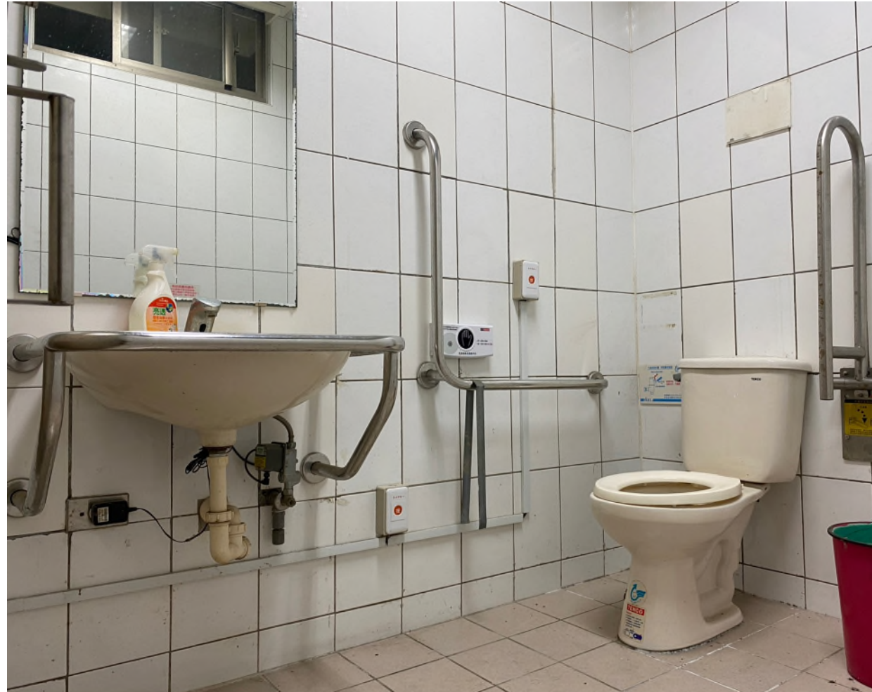
廁所盥洗室-無障礙廁所
